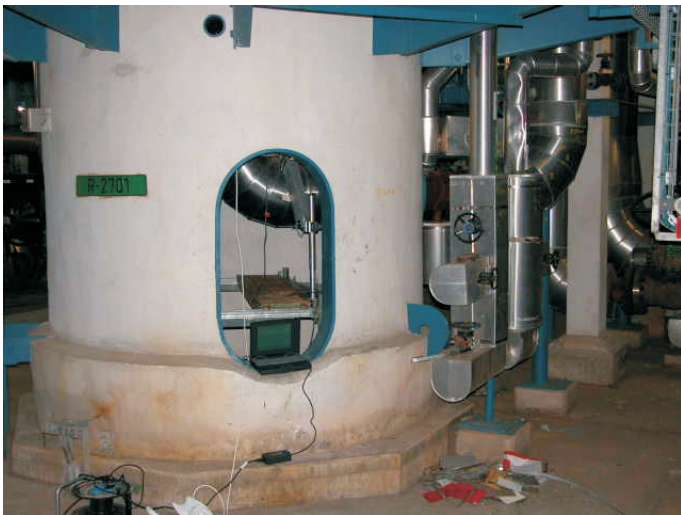
Standzarge des Reaktors mit 10" Eintrittleitung
